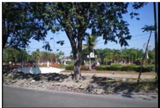
Gambar 1. Pembongkaran jalan di Jalan Arief Rachman Hakim, Surabaya
