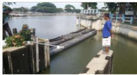
Sensor dan Tiang Penyangga
